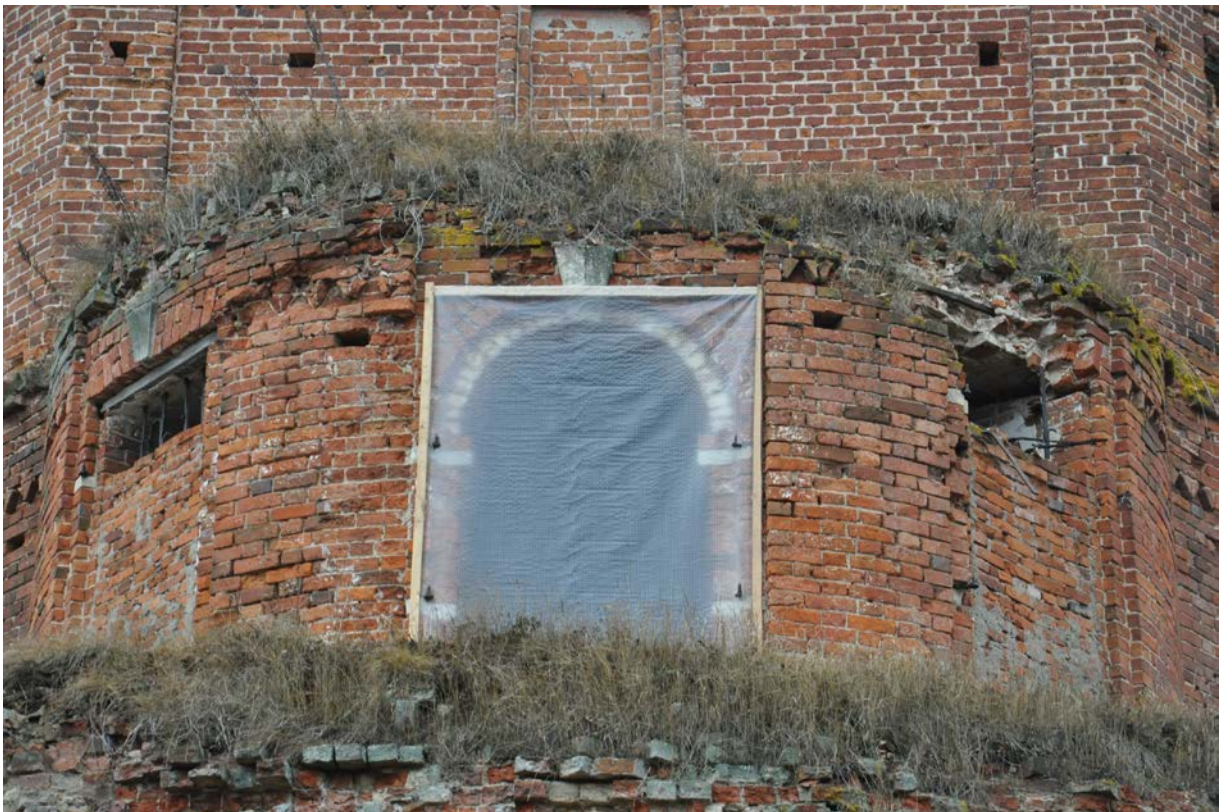
Фрагмент западного фасада. Дверной проем апсиды со следами примыкания галереи. Фото Н.Д. Ивашовой, 2019 г.
