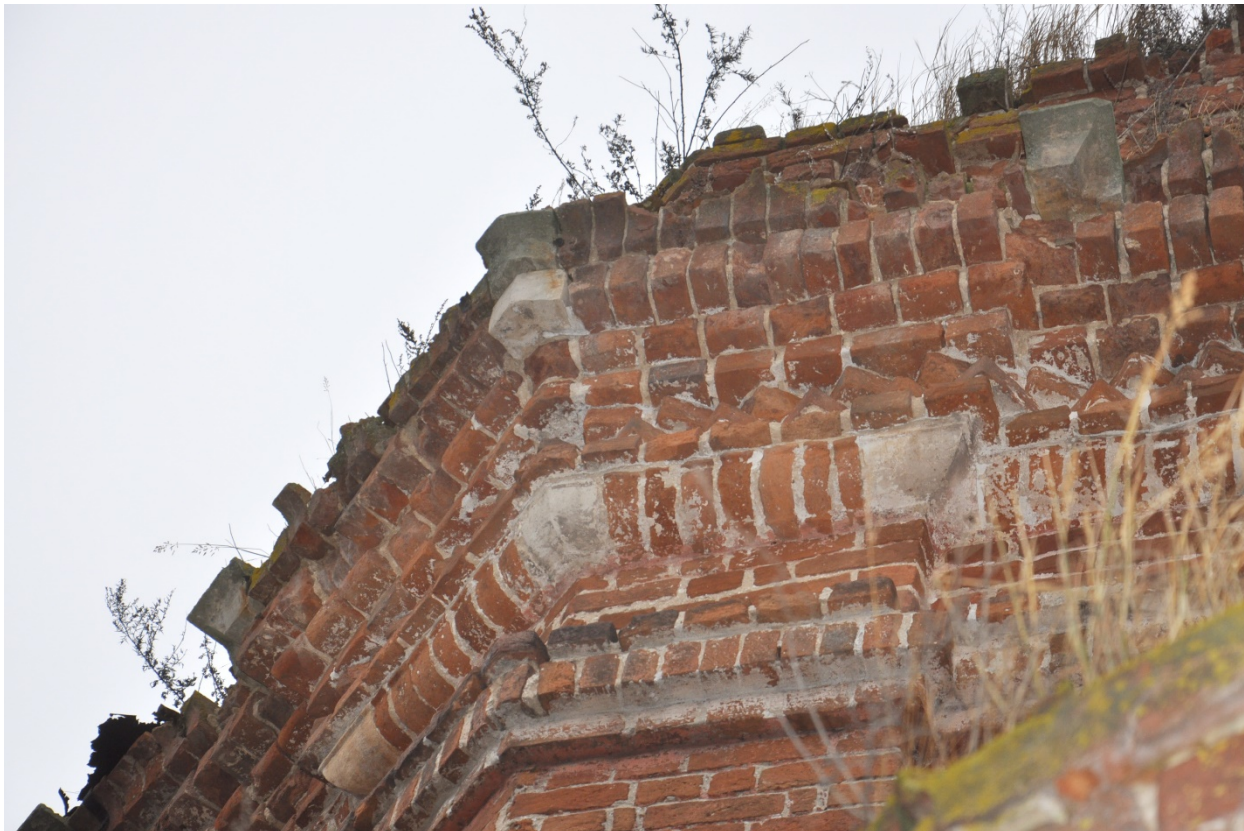
Фрагмент северный фасада. Фрагмент карниза восьмерика. Фото Н.Д. Ивашовой, 2019 г.
