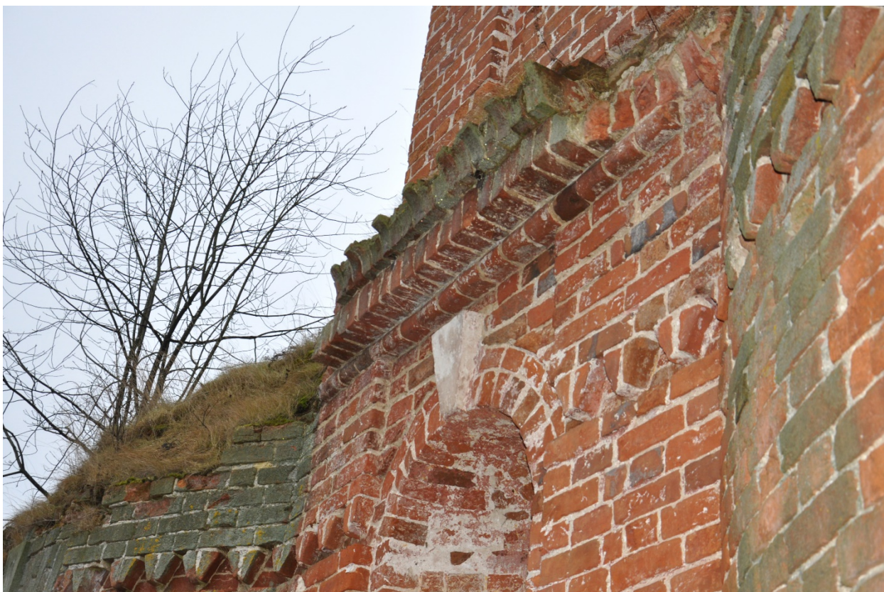
Фрагмент восточного фасада. Венчающий карниз апсиды. Фото Н.Д. Ивашовой, 2019 г.
