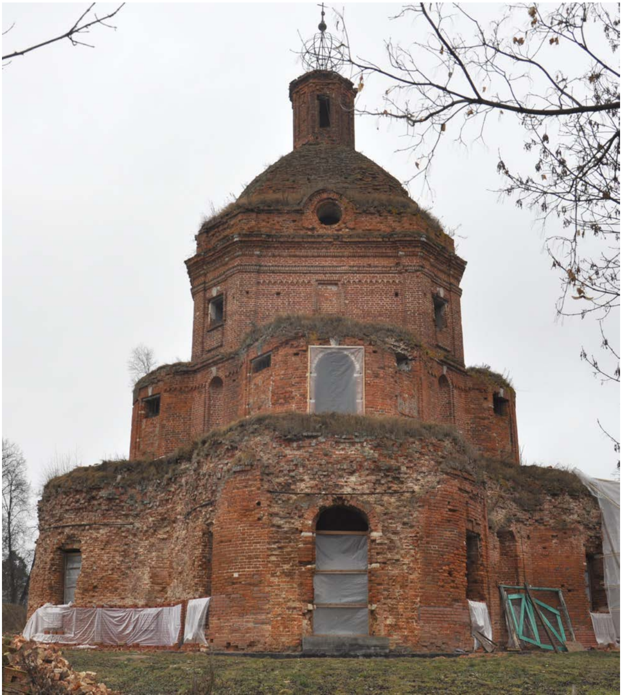
Западный фасад. Фото Н.Д. Ивашовой, 2019 г.
