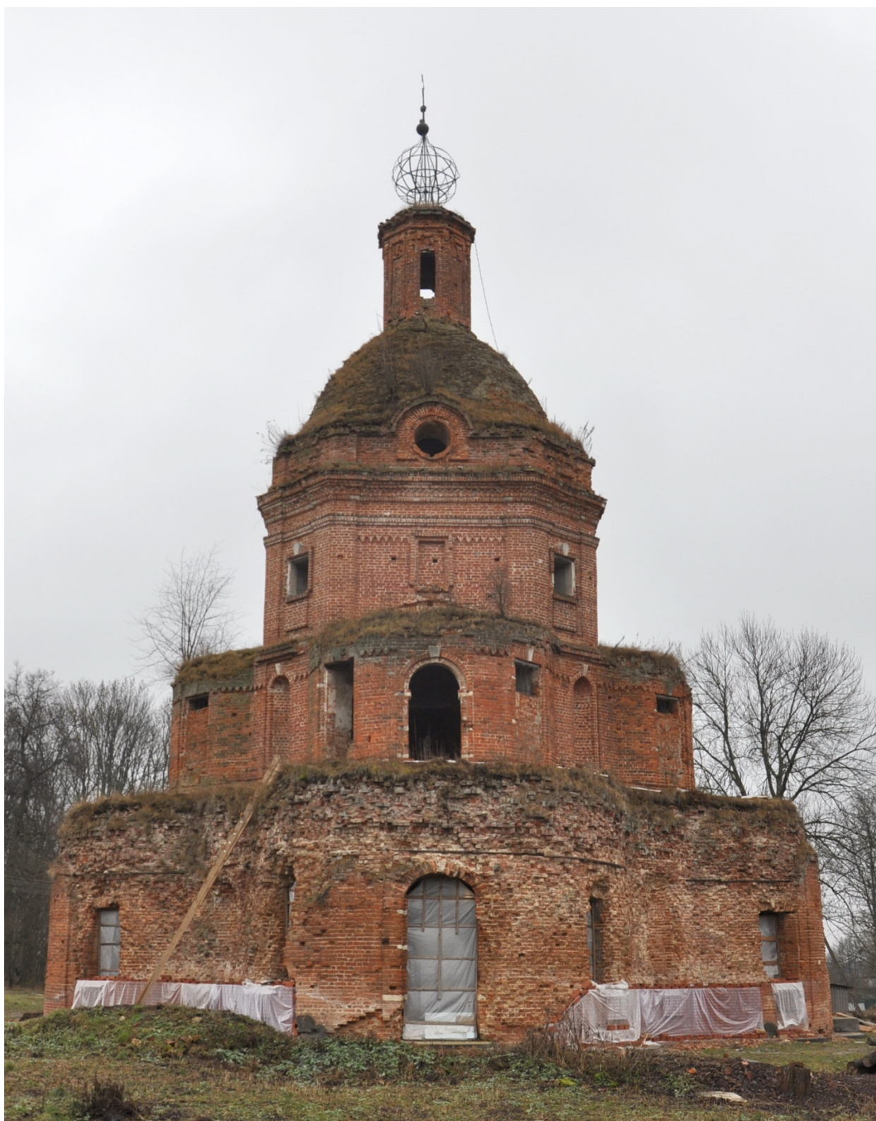
Северный фасад. Фото Н.Д. Ивашовой, 2019 г.
