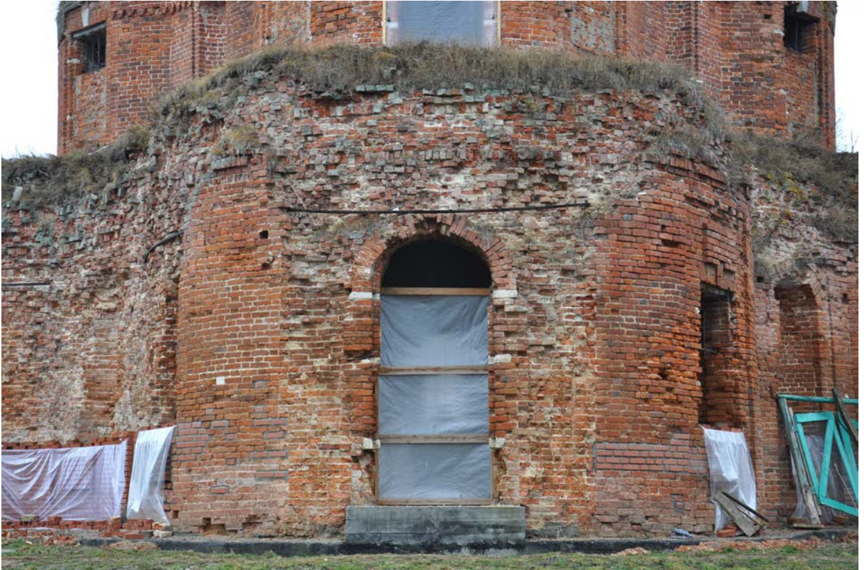
Фрагмент западного фасада. Следы на кладке примыкания галереи на первом ярусе. Фото Н.Д. Ивашовой, 2019 г.
